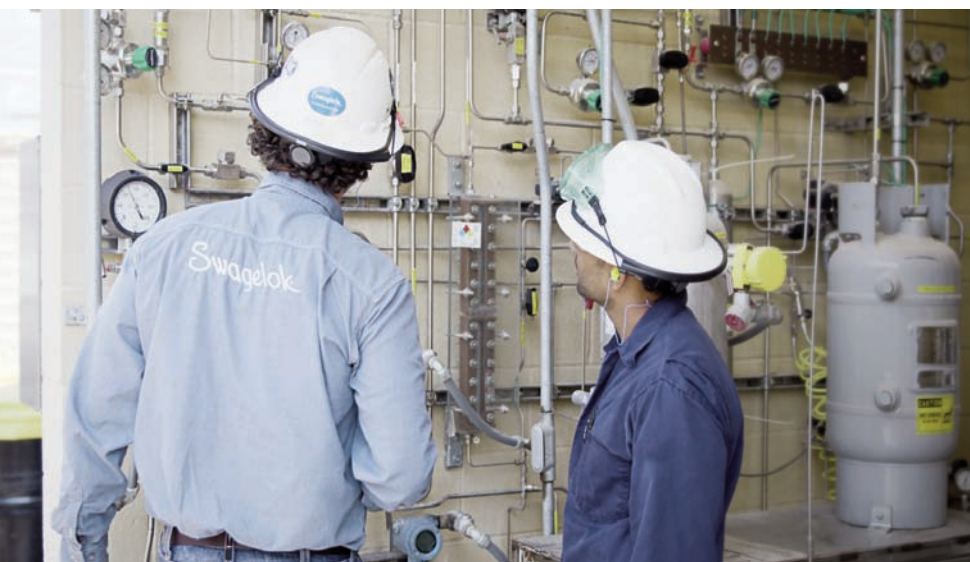
Los proveedores que ofrecen su apoyo pueden ayudar a los propietarios y operadores de las plantas a estar preparados para lo inesperado, anticipándose a las necesidades de suministro y ofreciendo almacenamiento de existencias temporales o en consigna.
