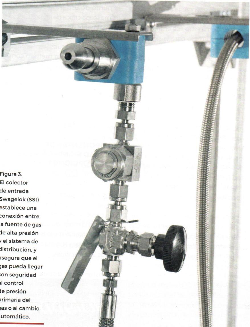
Figura 3. El colector de entrada Swagelok (SSI) establece una conexión entre la fuente de gas de alta presión y el sistema de distribución, y asegura que el gas pueda llegar con seguridad al control de presión primaria del gas o al cambio automático.
