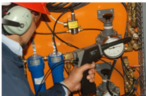
**1. Detección por ultrasonido.** Este procedimiento permite ubicar las fugas con mayor potencial en sistemas de presión positiva o en sistemas de vacío, que representan los puntos donde se pueden tener mayores pérdidas de recursos. Con este procedimiento también podemos detectar fugas en el interior de un sistema que no podrían ser detectadas mediante métodos de visualización externa.
