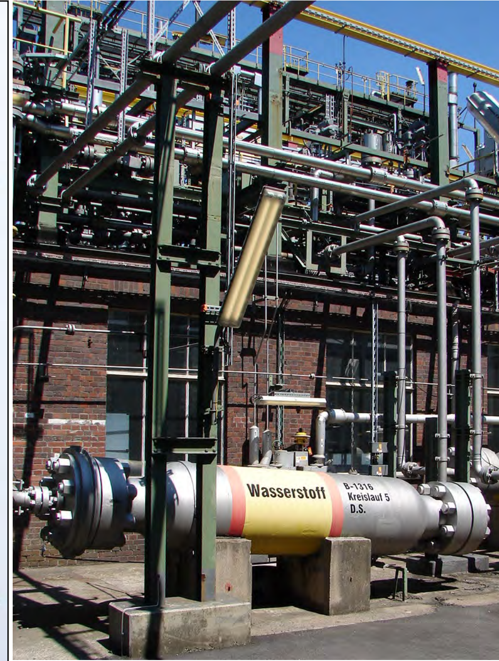
Wasserstoff-Speicher in der Industrie (efficientics)
